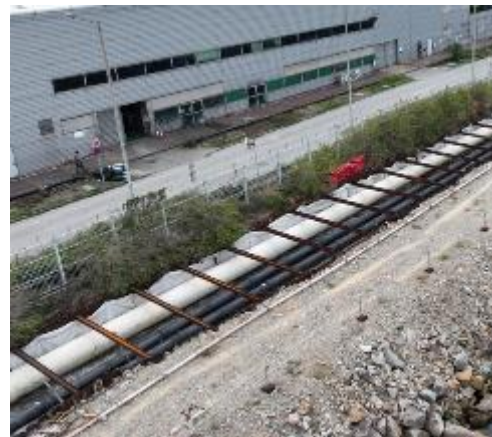
敷設食水輸水管 及污水壓力管道
