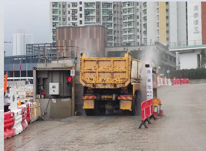
地盤出口設立洗車設施
