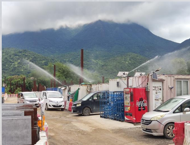
定時於工地進行灑水防止塵土飛揚
