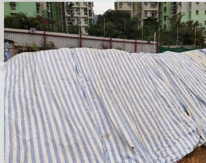
以帆布遮蓋建築物料防止塵土飛揚
