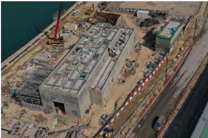
建造海水抽水站
