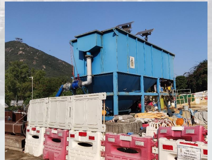
設置污水處理設施
