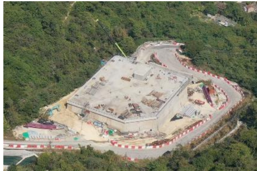
建造海水配水庫
