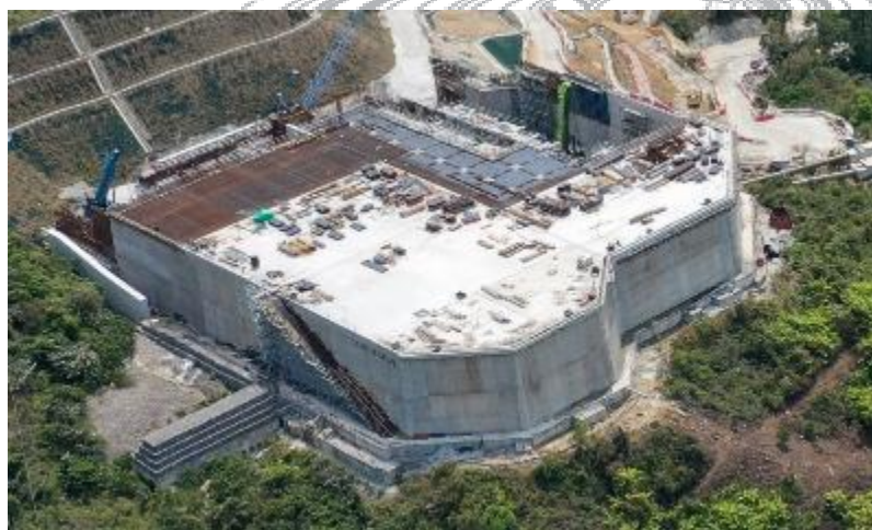
建造食水配水庫
