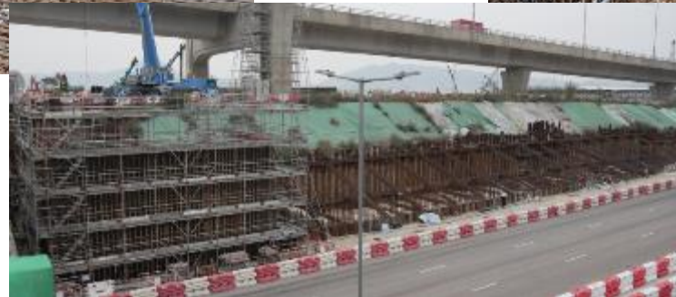
臨時交通安排，擋土牆及橋樑工程
