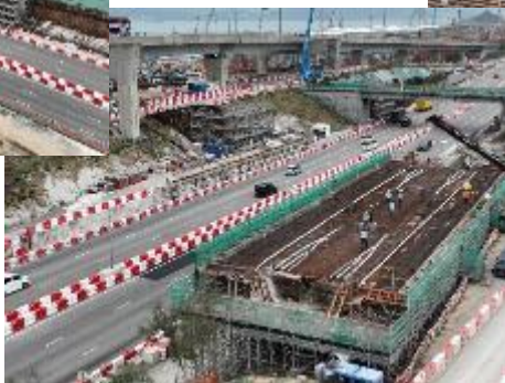
臨時交通安排，擋土牆及橋樑工程
